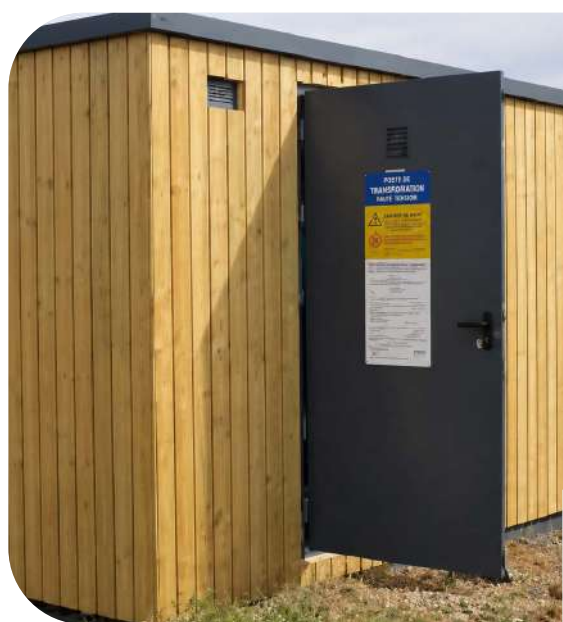
Mise en place d'un local technique avec bardage bois.
