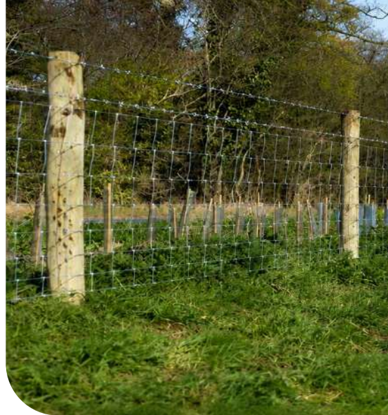
Mise en place d'une clôture de type agricole avec poteau bois.
